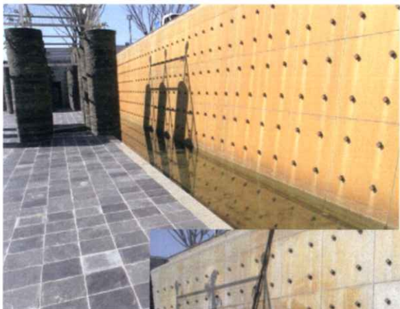
流水面施工前
