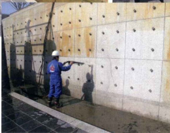
流水面施工中
