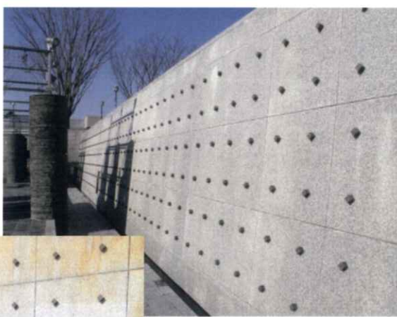
流水面施工後
