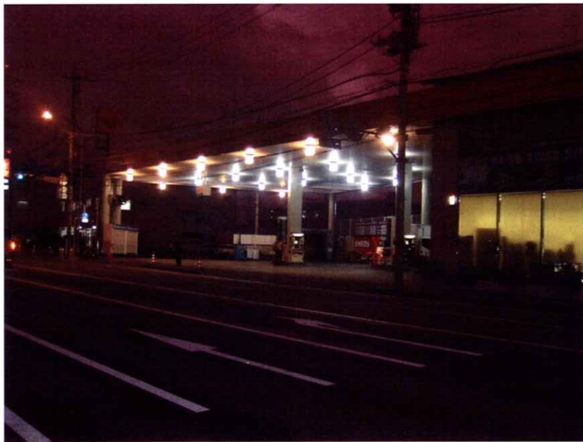
夜間点灯状況 (午後7時 晴れ)
